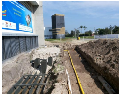
MONTAGEM DE REDE DE ESGOTO, GASODUTO DE ALTA PRESSÃO E DRENAGEM
