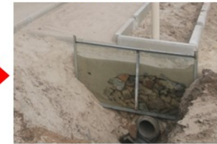
USO DE BRITA (CAPA DRENANTE DO SISTEMA DE CAPTAÇÃO PLUVIAL) E AREIA NA CICLOVIA
