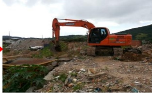
O LIXO DA CONSTRUÇÃO CIVIL É TRIADO EM UNIDADE DE RECICLAGEM E SEPARADO MECANICAMENTE E ENCAMINHADO A CENTRAL DE BRITAGEM
