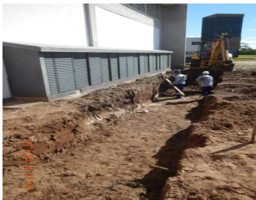
ABERTURA DE VALA
