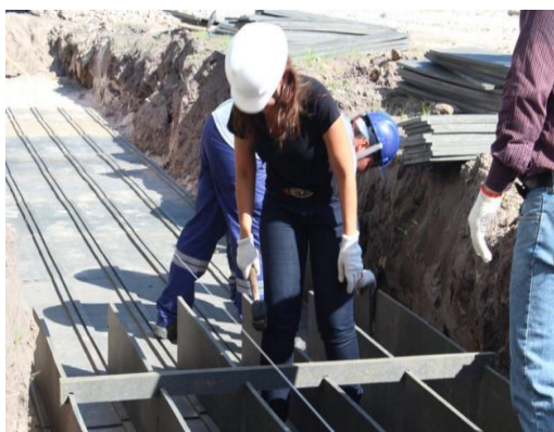
MONTAGEM DO SISTEMA DE BLOQUEIO
