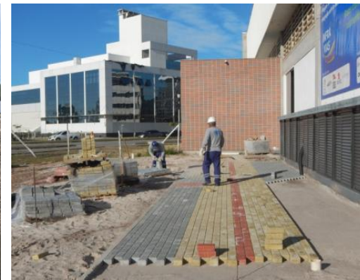
COBERTURA COM BLOCOS DE CONCRETO
