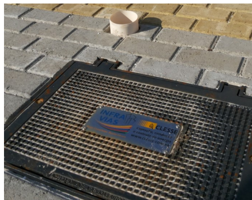
FUTURA INTEGRAÇÃO COM SISTEMA DE ENERGIA RENOVÁVEL
