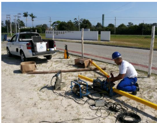
GASODUTO DE ALTA PRESSÃO COM VESTAMID® PA 12 PIPE
