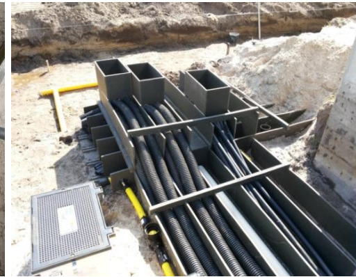
SISTEMA DE DERIVAÇÃO EM ESQUINA
