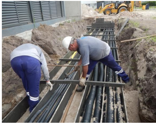
IMPLEMENTAÇÃO DAS REDES DE INFRAESTRUTURA
