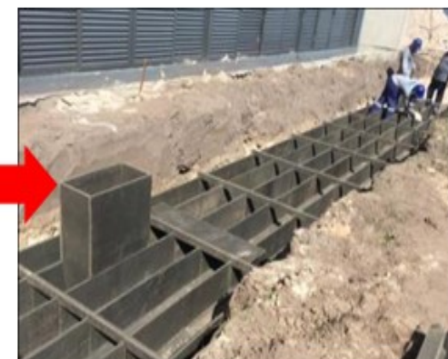
IMPLANTAÇÃO DAS PLACAS DE PLÁSTICO RECICLADO DO SISTEMA INFRÁVIAS
