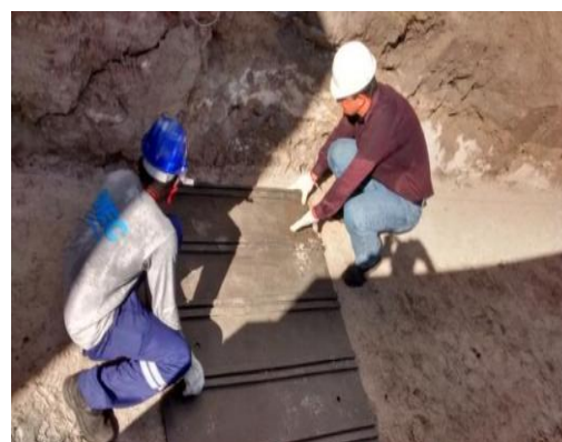
COLOCAÇÃO DE BASE DE PLÁSTICO RECICLADO
