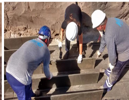
MONTAGEM DOS PAINÉIS DE PLÁSTICO RECICLADO
