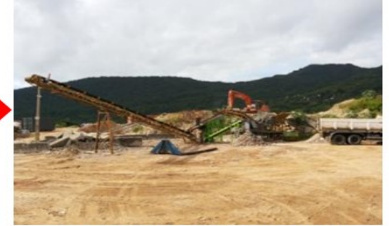
NA CENTRAL DE BRITAGEM O ENTULHO É PROCESSADO E PENEIRADO
